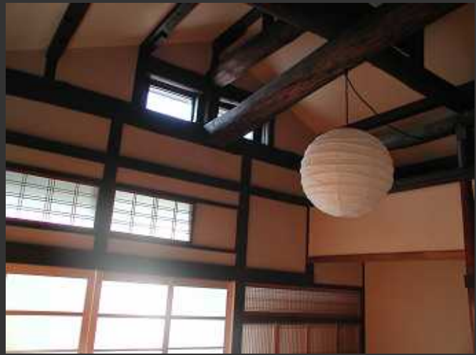
天井を解体し、梁を出し、吹抜けに変更。 更に、高窓を採用することで、明るく開放的な空間になりました。
