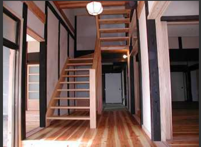
モダンな印象に変わった階段廻り。 内装には無垢板や珪藻土などの自然素材をふんだんに採用。
