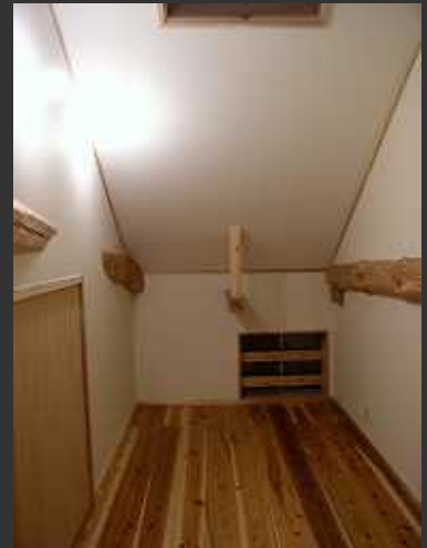
屋根裏だった場所に、洋室を3部屋確保。 天井を解体し、天窓をつけることで明るさを確保。
