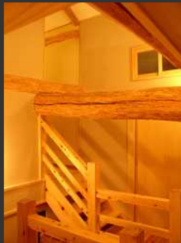
オープン手摺と梁を出すことで開放感が出ました。 高窓をつけることで明るさを確保しました。
