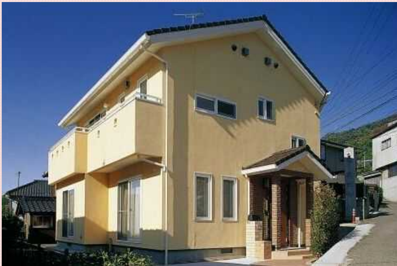
平成 19 年 10 月完成 安芸区中野 Y 様邸
